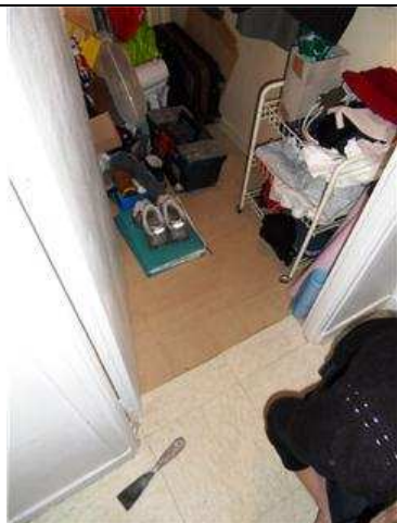
002 - Appartements - Cellier LOT 0202 PH23 : Colle noire et ragréage PRE:006
